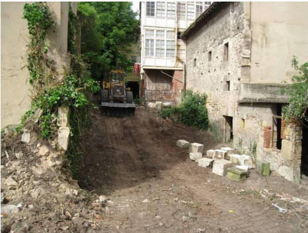
Trabajos de limpieza en la zona de las Tenerías
