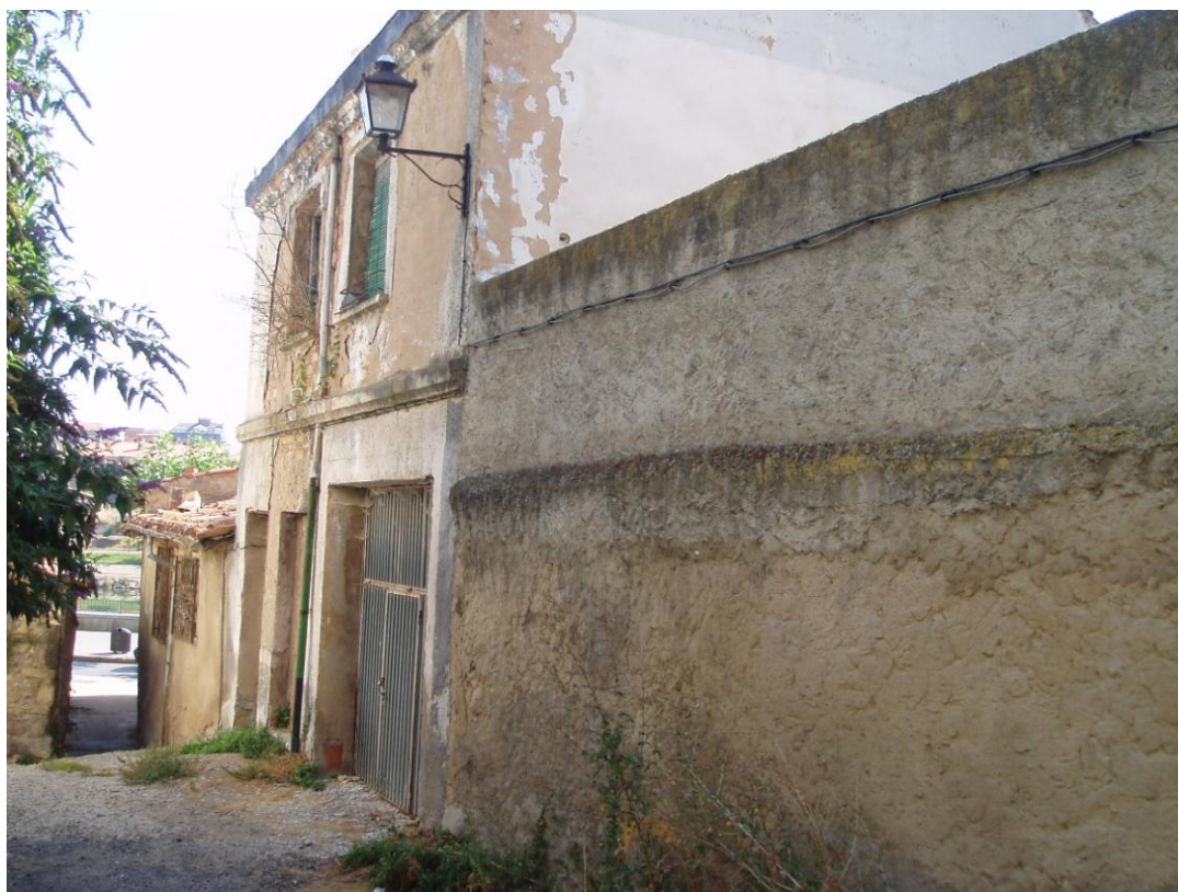
Tras el muro está la fuente y lavadero de una tenería
