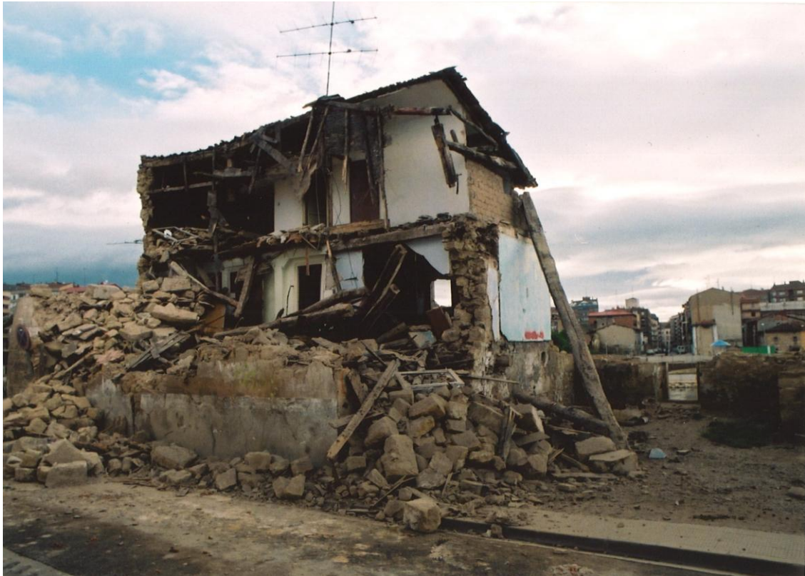
Trabajos de demolición de un antiguo edificio que albergó tenería en la zona del Valle
