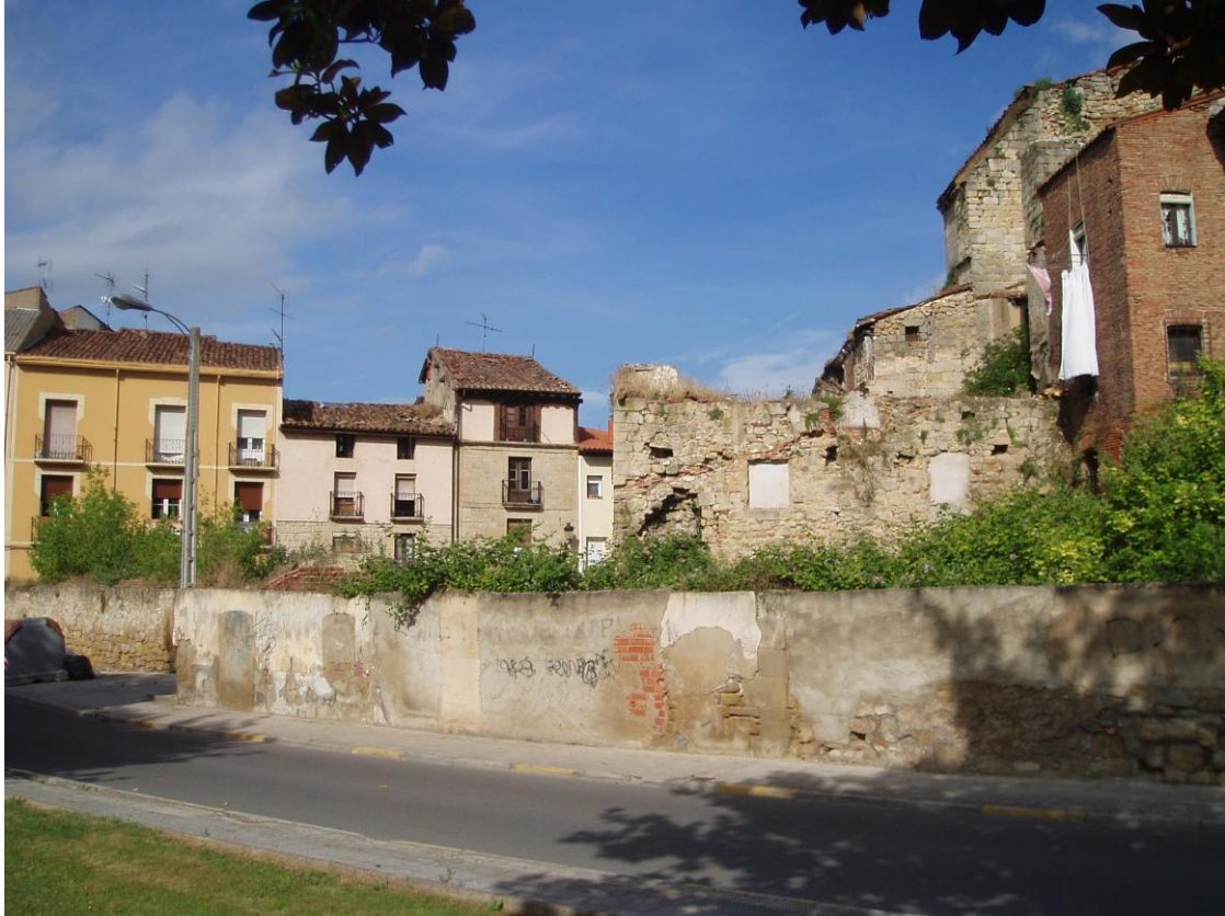
Tenería de la zona de San Juan en calle Oroncillo, nº 38
