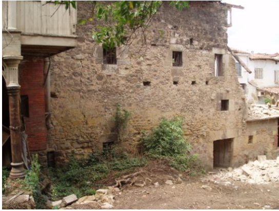
Edificio en demolición de una antigua Tenería
